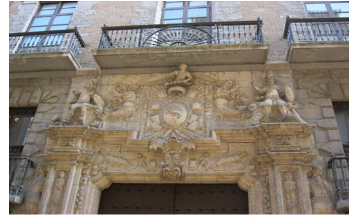
Detalle de la fachada principal
