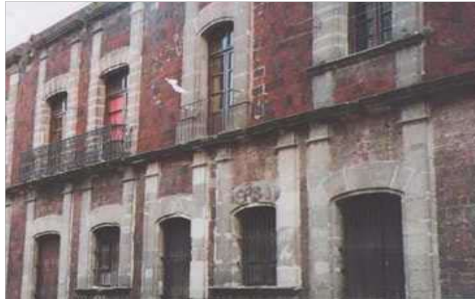
Casa-palacio de los Echeberz en Nuevo México
