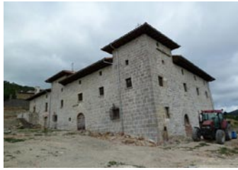
El Palacio de Cabo de Armería de Ochovi, en fase de restauración.
