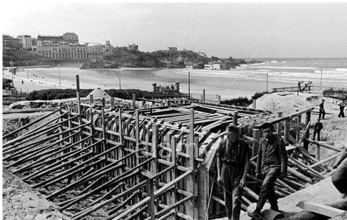
Biarritz. Construcción de Bunker
